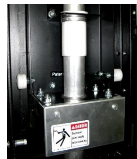
(6) Zamontować osłonę końcową
